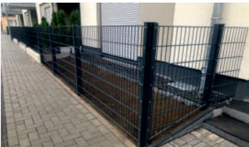
Der Doppelstabmattenzaun ist der heutige Standard bei Einfriedungen im privaten als auch im gewerblichen Bereich. Die Horizontaldoppeldrähte, verschweißt mit Vertikaldrähten, verleihen dem Zaun eine optimale Stabilität.
