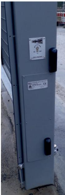
Steuerung im Pfosten integriert
